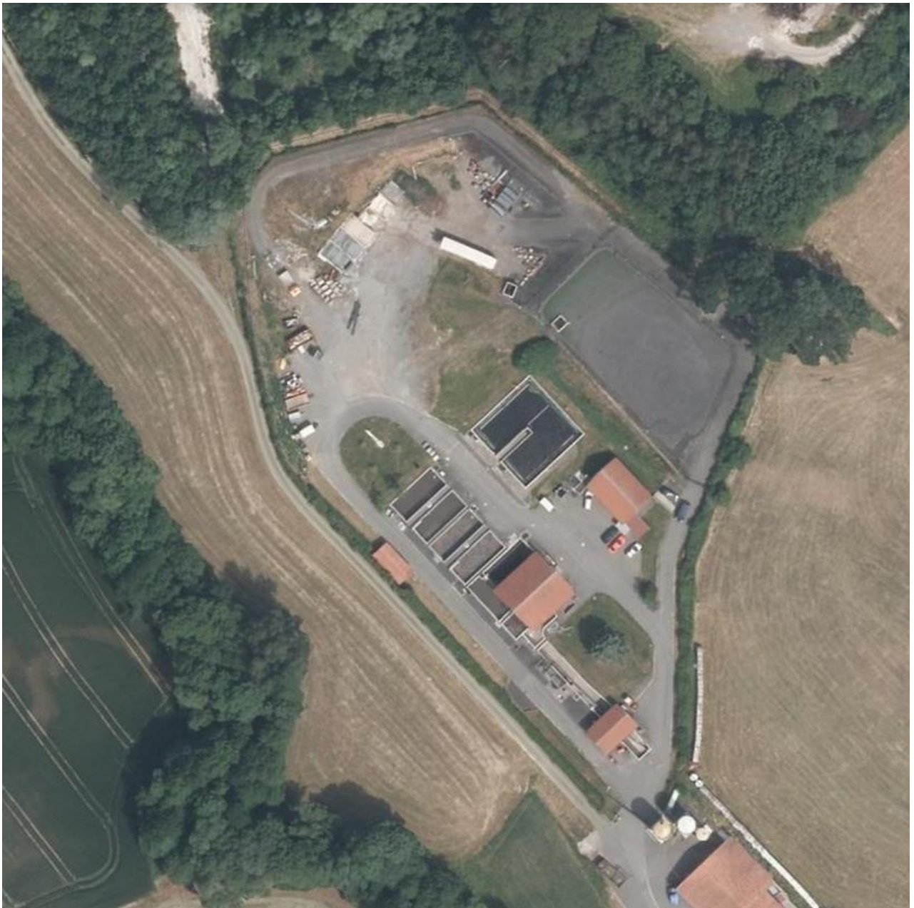
Abbildung 3-3: Luftbild der Kläranlage
